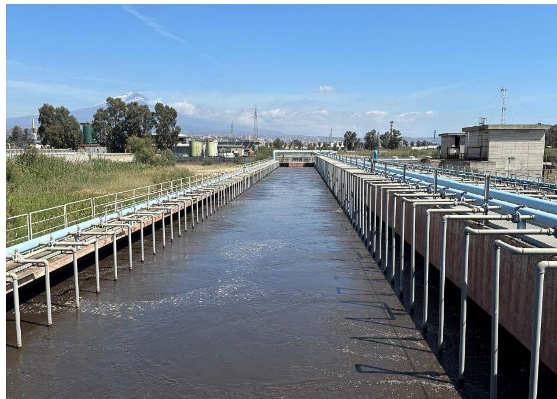
Foto vista frontale del reattore biologico (vasca ossidativa)
