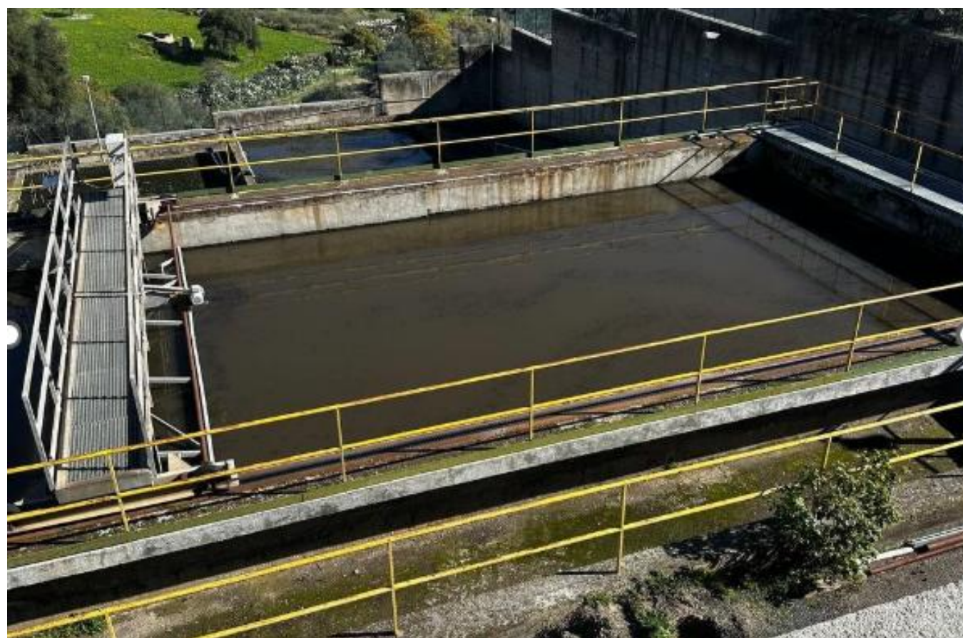
Foto sedimentatore secondario impianto di Gagliano
