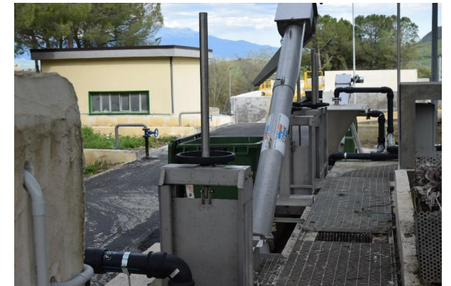
Stazione di grigliatura e dissabbiatura dopo gli interventi
